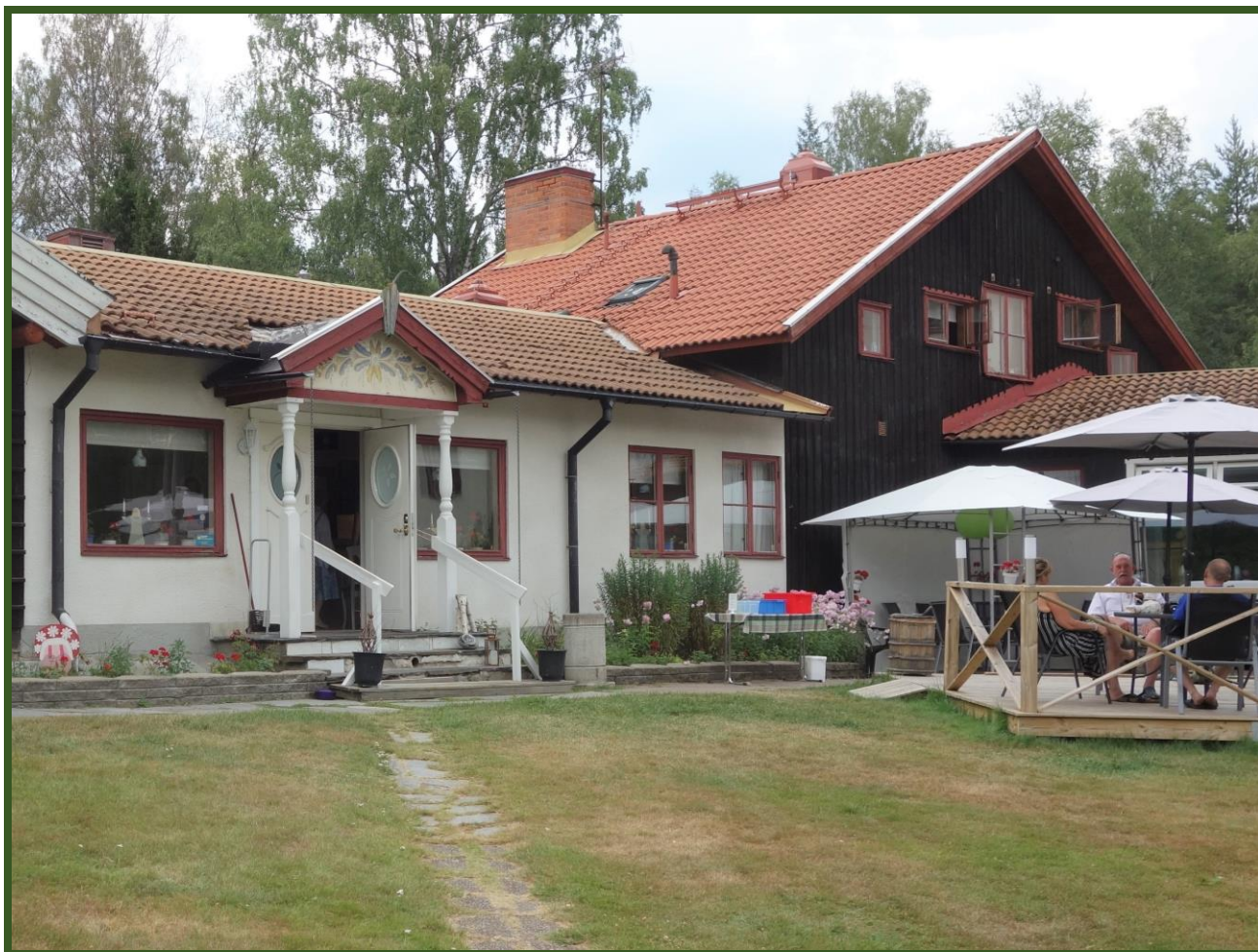
Entrén med uteplats.
